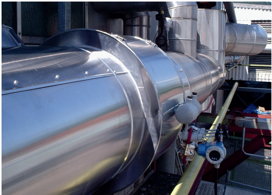
Applicatie waarin de hoeveelheid warmte, getransporteerd als stoom gemeten wordt met een meetinrichting die voldoet aan norm NEN-EN-ISO 5167-1:2003
