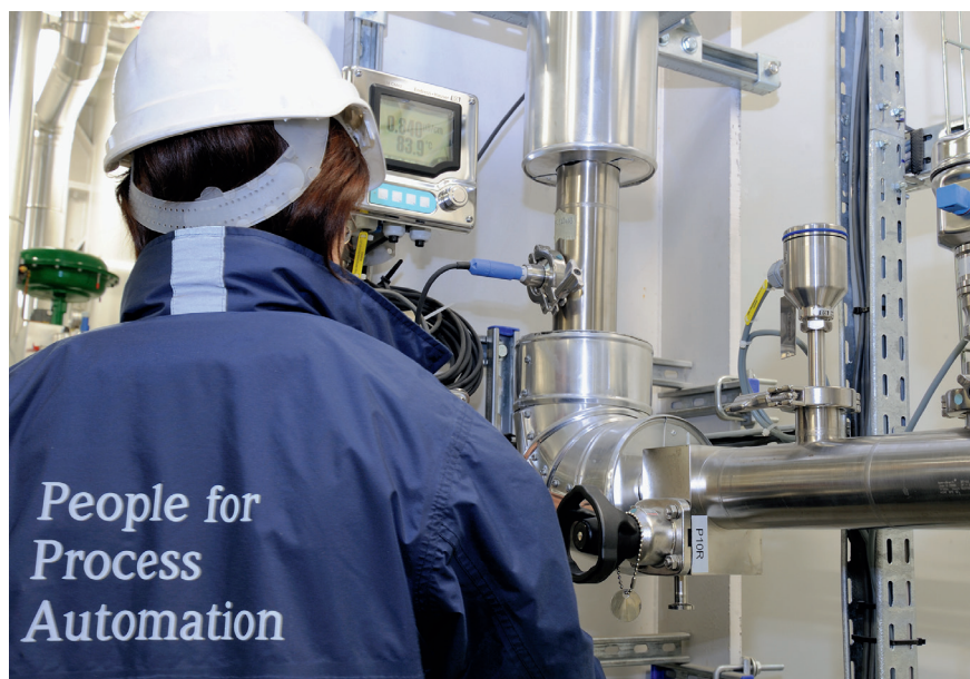
GMP opgeleide technicus van Endress+Hauser tijdens een inspectie van een WFI-loop.
